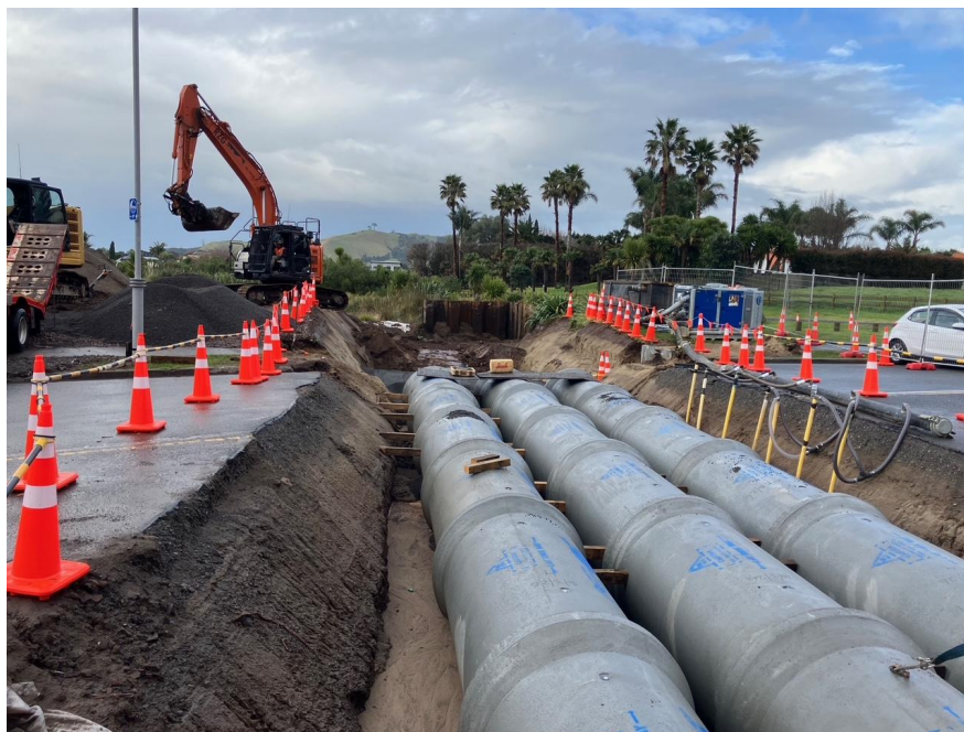
Gravatt Road Culverts
